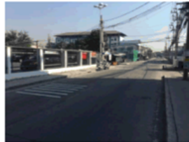
減速マークを表示した路面 (Yuasa Battery (Thailand) Pub)
