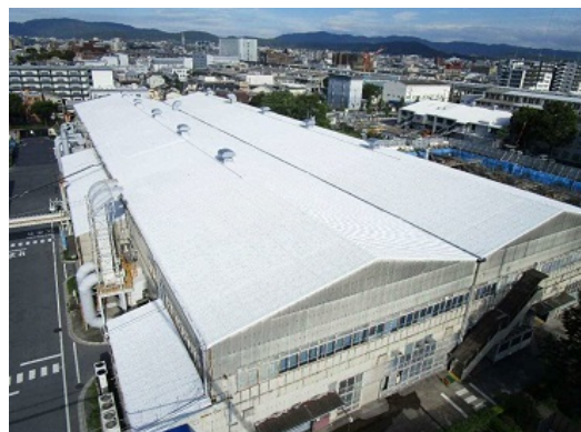
遮熱塗装後の工場の屋根
