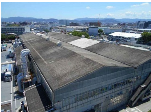
遮熱塗装前の工場の屋根
