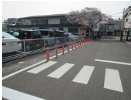
ソフトボール設置による歩車分離 (京都事業所)
